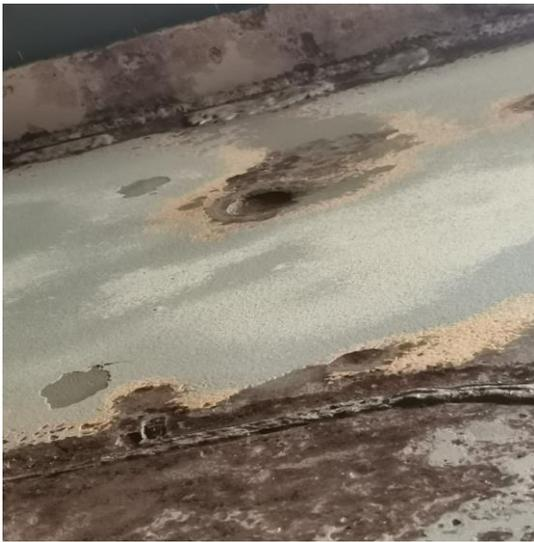
Fig.43 Piqures sur tôle de bordé de fond Avant Bd
