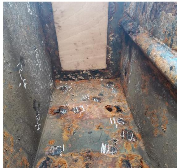
Fig.46 Piqures et présence de cavité sur la tôle des caissons des BOXCOOLER
